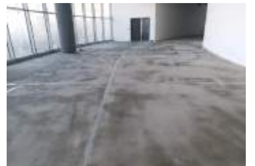
EPOKSİ ASTAR ÜZERİ KUMLAMA
