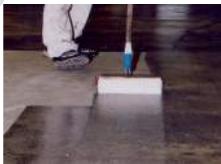
EPOKSİ ASTAR UYGULAMASI
