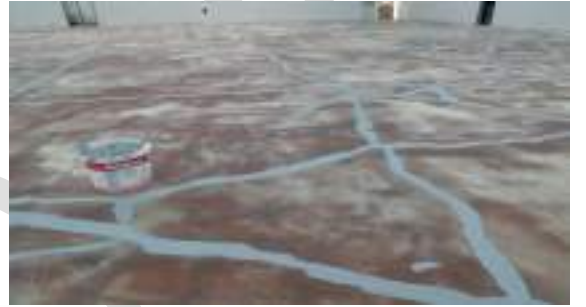
EPOKSİ MORTAR HARÇ UYGULAMASI
