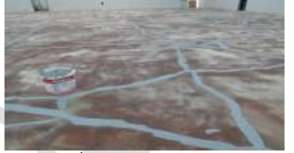
EPOKSİ MORTAR HARÇ UYGULAMASI
