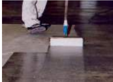
EPOKSİ ASTAR UYGULAMASI
