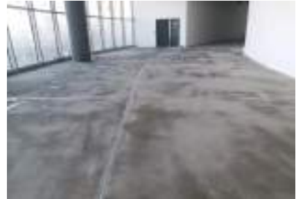
EPOKSİ ASTAR ÜZERİ KUMLAMA
