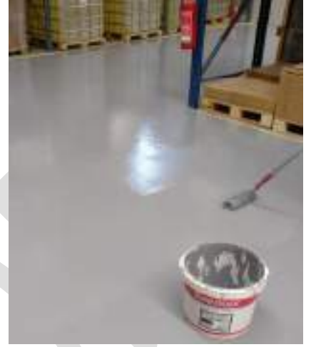
EPOKSİ BOYA UYGULAMASI
