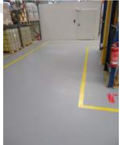
EPOKSİ BOYA ÇİZGİ UYGULAMASI
