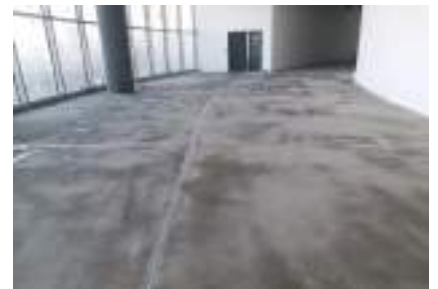
EPOKSİ ASTAR ÜZERİ KUMLAMA
