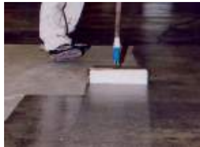
EPOKSİ ASTAR UYGULAMASI
