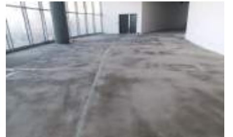
EPOKSİ ASTAR ÜZERİ KUMLAM
