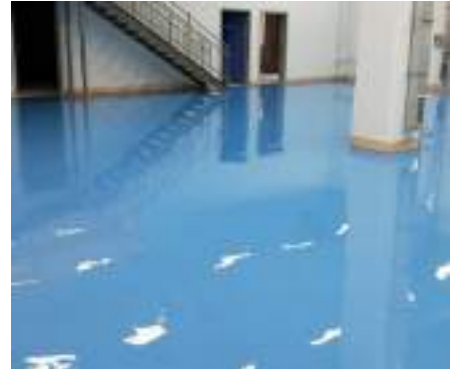
SELF LEVELING EPOKSİ UYGULAMA
