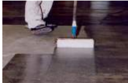
EPOKSİ ASTAR UYGULAMASI
