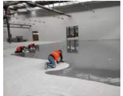
SELF LEVELING EPOKSİ UYGULAMA
