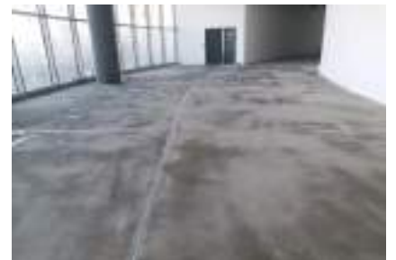
EPOKSİ ASTAR ÜZERİ KUMLAMA
