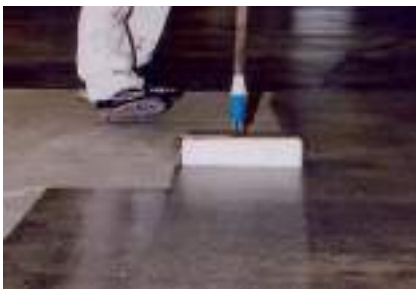
EPOKSİ ASTAR UYGULAMASI
