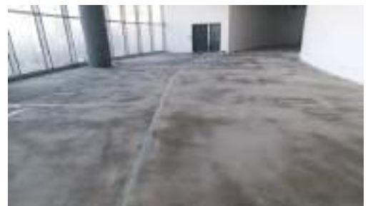
EPOKSİ ASTAR ÜZERİ KUMLAMA
